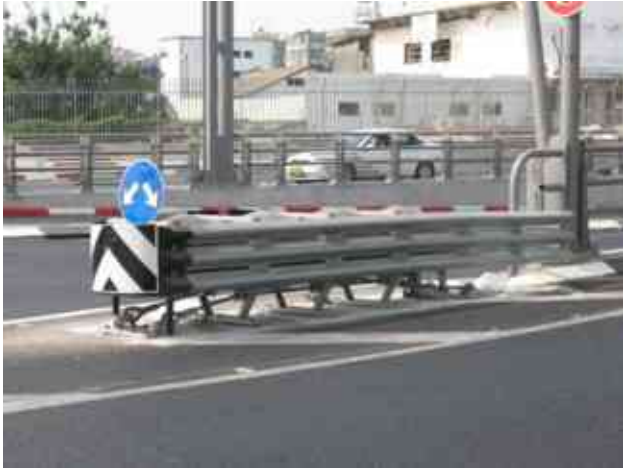
جدار ممتص للطاقة مُعدّ للشوارع داخل المدينة، ملائم لسرعات تتراوح بين 50-90 كم/ساعة.
