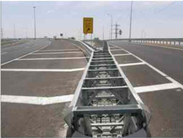
جدار ممتص للطاقة مُعدّ للشوارع السريعة، ملائم لسرعات تتراوح بين 60-120 كم/ساعة.
