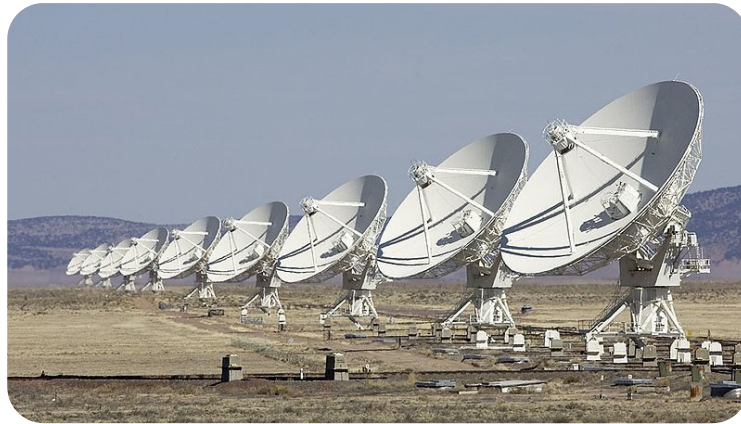
صورة 6.4 مجموعة من التليسكوبات في نيو- مكسيكو، الولايات المتحدة الأمريكية. وظيفتها التقاط الأشعة من الفضاء الخارجي التي يتراوح أطوال أمواجها بين 0.6 – 4.1 متراً (المصدر: أنظر ملحق ج)
