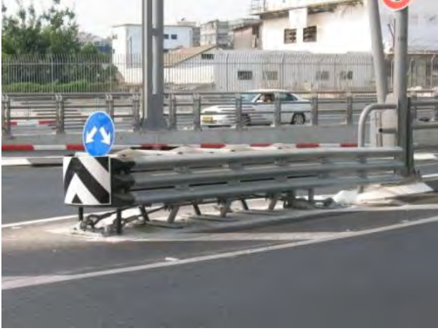
جدار ممتص للطاقة مُعدّ للشوارع داخل المدينة، ملائم لسرعات تتراوح بين ٩٠-٥٠ كم/ساعة.
